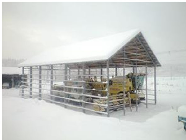
屋根と鉄骨だけの倉庫に格納した機械たち
